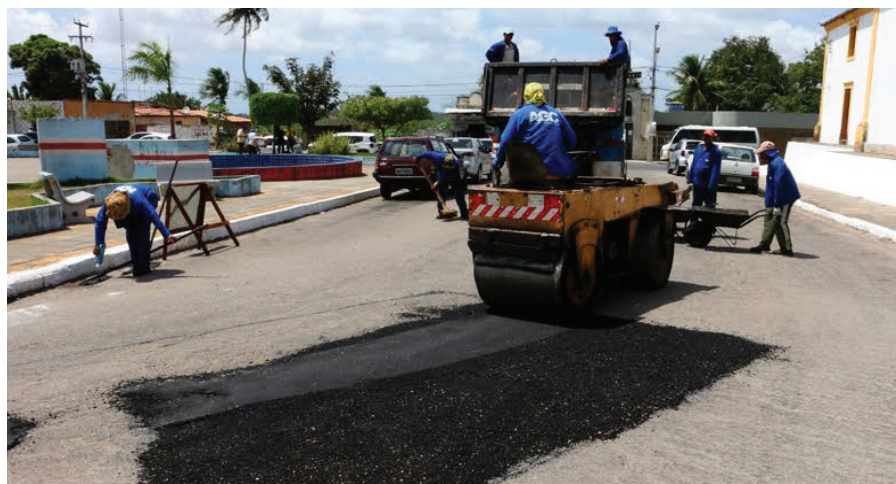
O trecho recuperado contempla 16 km e é utilizado para acesso ao Aeroporto Aluizio Alves
